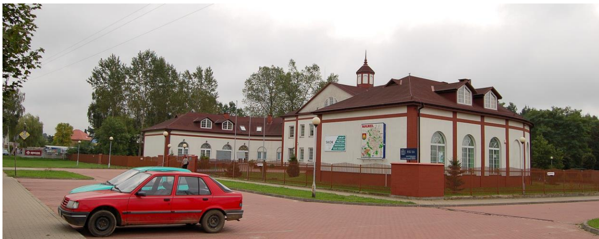
Zdjęcie 13. Budynek Urzędu Gminy w Kołbieli.
