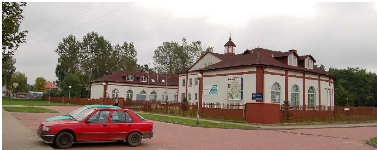
Zdjęcie 13. Budynek Urzędu Gminy w Kołbieli.
