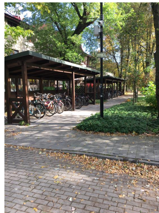
Rys. 2.4 Zadaszony parking B+R w Podkowie Leśnej
